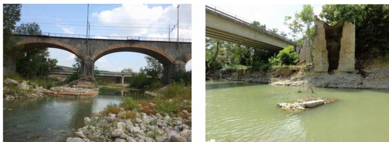
Fig. 4 - Le fondazioni dei ponti, scalzate alla base, manifestano l'entità del processo di erosione verticale.
