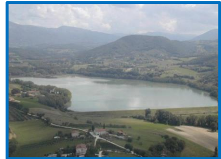
Diga de l'Aia (Lago di Recentino)
