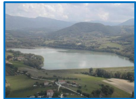
Diga de l'Aia (Lago di Recentino)
