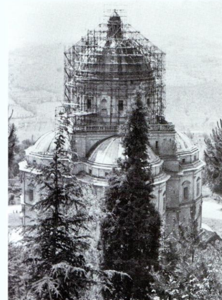
fig. 11. La Cupola durante i lavori di sostituzione della copertura in piombo (1972). (Foto Dr. E. Mammoli).
