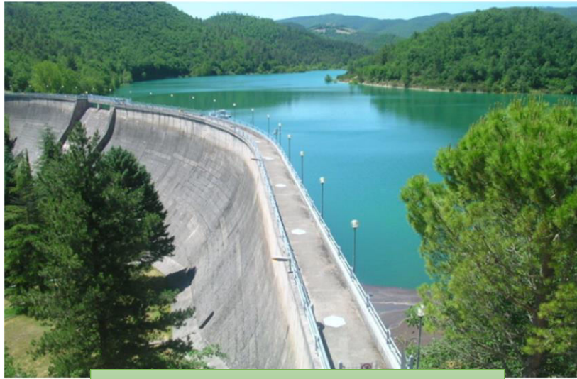
Diga sul T. Marroggia - Spoleto
