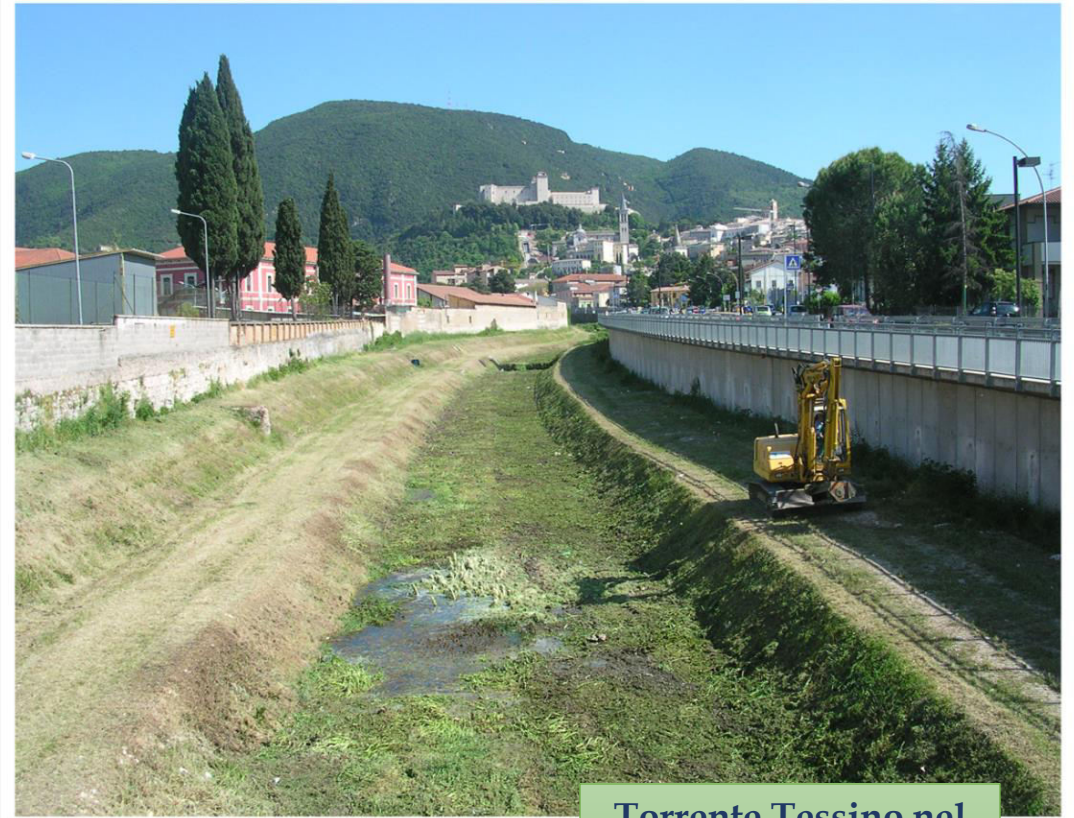
Torrente Tessino nel tratto urbano di Spoleto
