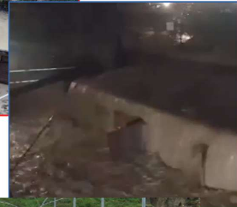
Copertura del Ravone ammalorata, sfondamenti e allagamenti.
