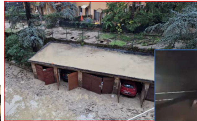
Copertura del Ravone ammalorata, sfondamenti e allagamenti.
